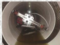
樹脂製の新しい内壁を形成
