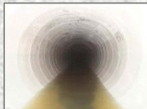
工事完成後の下水道管の内部
