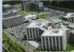
病院の屋上ヘリポート確認
