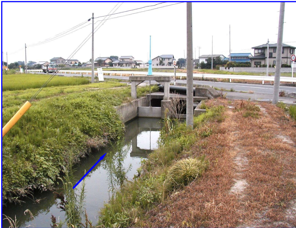
熊谷市（旧大里町）中恩田地先
