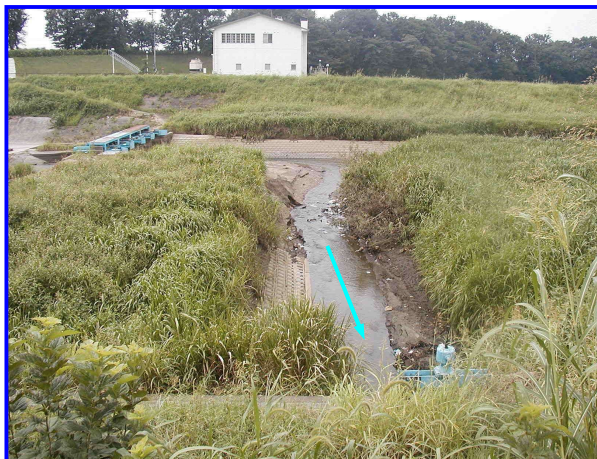
取水口への導水路
