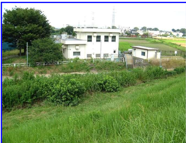
出丸揚水機場
