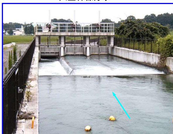
大里幹線分水工
