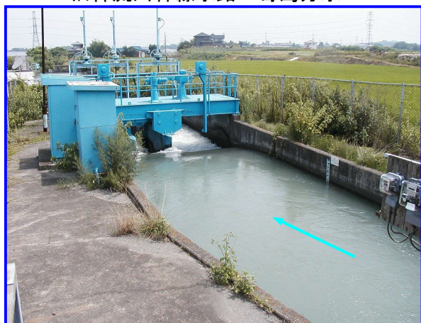
旧神流川幹線水路・寄島分水工
