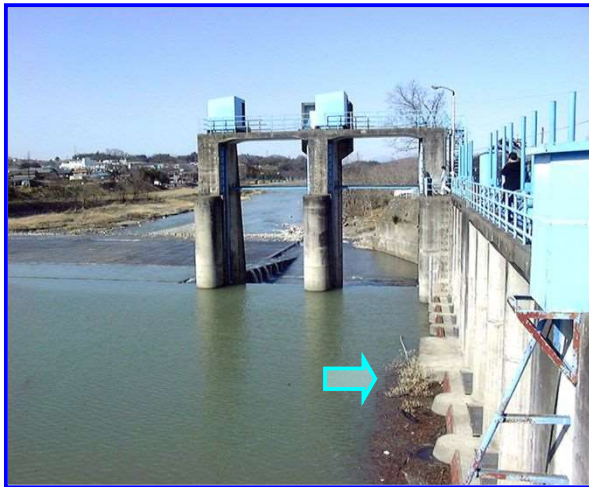
合口筋取水口
