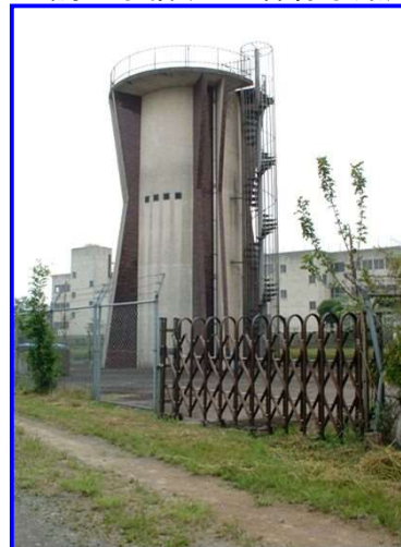
調圧水槽(上里幹線水路)
