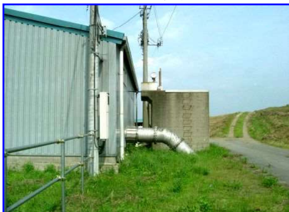
熊谷市（旧妻沼町）上須戸地先
