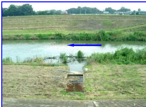
熊谷市（旧妻沼町）上須戸地先
