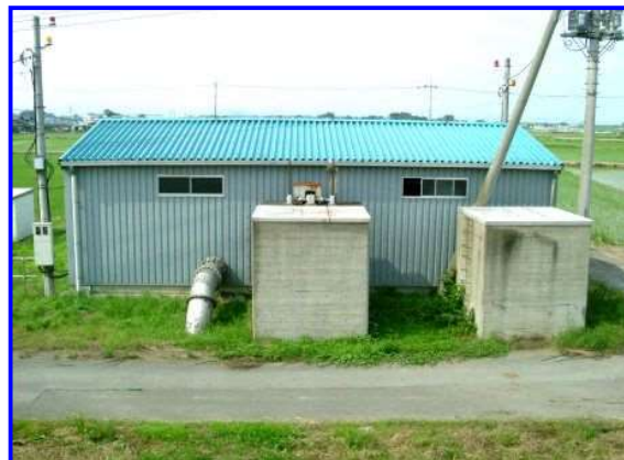
熊谷市（旧妻沼町）上須戸地先
