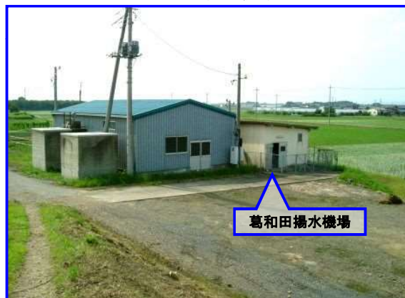
熊谷市（旧妻沼町）上須戸地先
