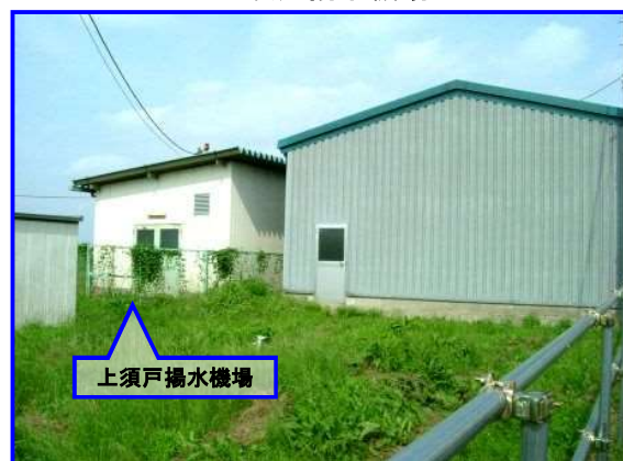
熊谷市（旧妻沼町）上須戸地先
