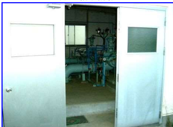
熊谷市（旧妻沼町）上須戸地先
