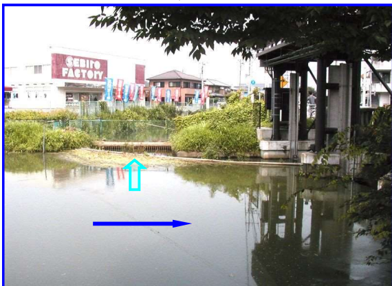
大橋井堰第一用水取水口
