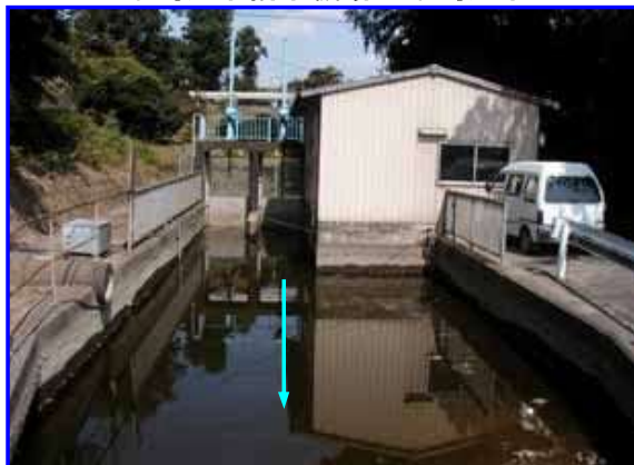
中島用水揚水機場・中島用水
