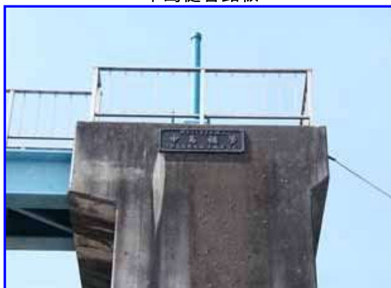
中島樋管銘板
