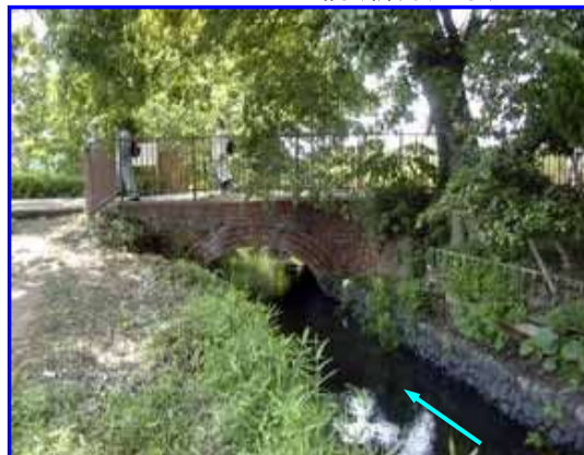
深谷市上敷免地先
