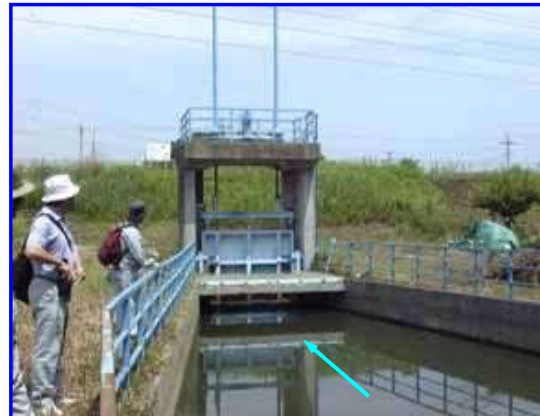
唐沢川伏越工（上流部）
