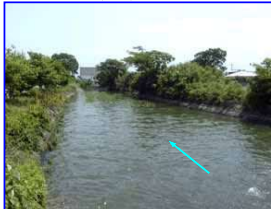
備前渠用水路
