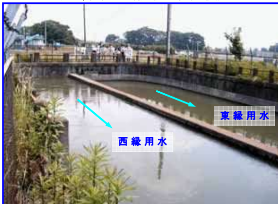
瓦葺伏越工（綾瀬川伏越後）
