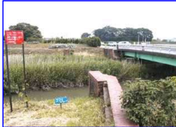
上尾市瓦葺地先
