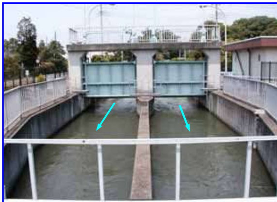
柴山伏越工（元荒川伏越）
