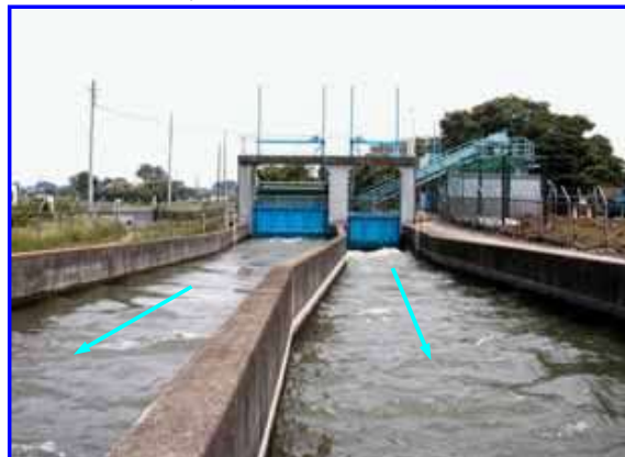
瓦葺伏越工（綾瀬川伏越前）
