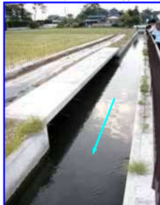
元和川用水路（魚の休憩所）
