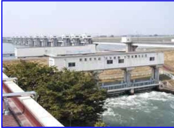
利根大堰・須加樋管
