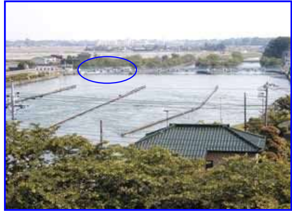
須加沈砂池・大分水工
