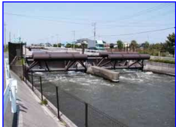
南方用水・四ヶ村用水分水工
