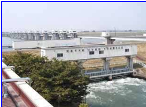
利根大堰・須加樋管
