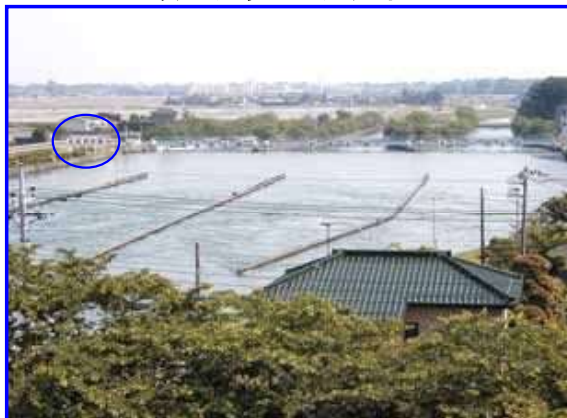
須加沈砂池・大分水工
