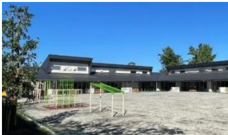
閉校した小学校跡地を利用した『新中央保育所』がオープン
