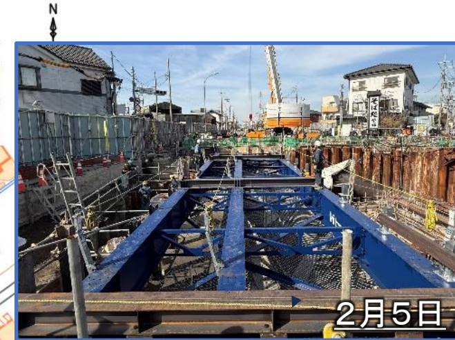
チュウ4近接部(1車線分)は仮橋構造
