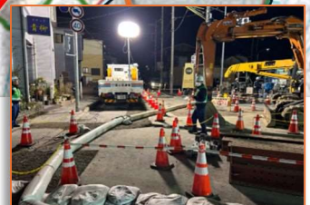
チュウ4からチュウ3へ ポンプ車による汚水移送
