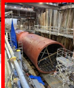
埋め戻す前の 下水管の様子 (地下から撮影)
