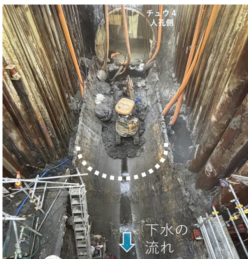
下水道管破損箇所の下流部から上流（チュウ4 人孔）に向けて撮影した現場写真
