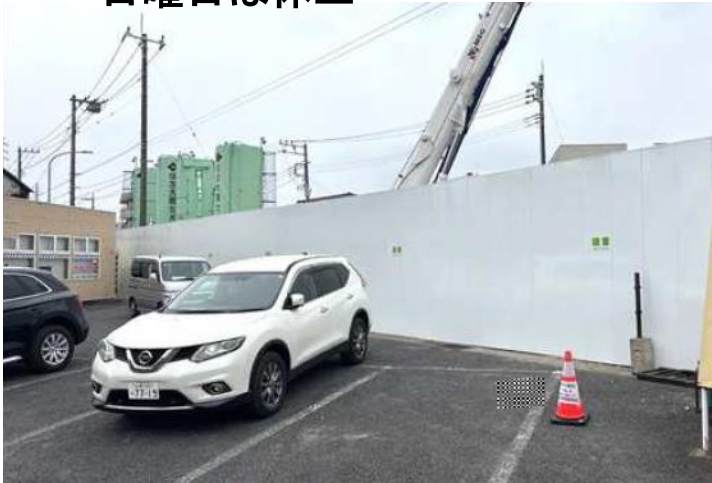
写真. 防音パネル設置状況
