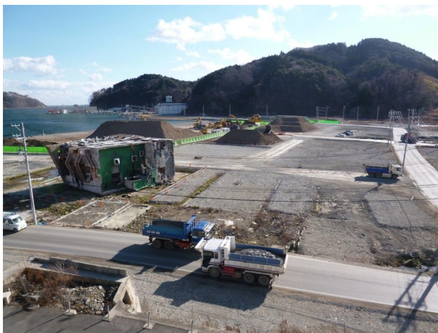
写真：女川町の復興状況（平成 25 年 1 月 11 日時点）
