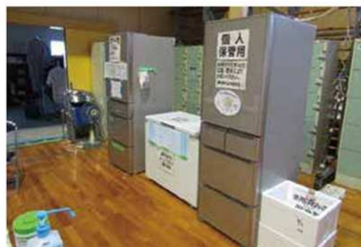
設置された冷蔵庫(第二福田小学校)
