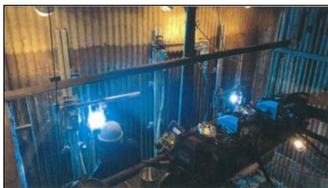
ボイラー火炉における現地施工の様子
