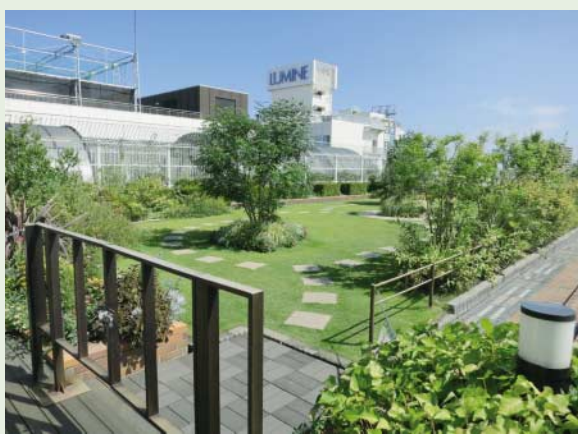
写真2-8-1 商業施設の屋上緑化の例
