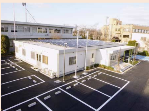
写真3-11-1 自動車税事務所太陽光発電設備
