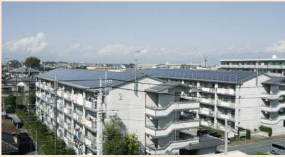
写真3-13-1 屋根貸し太陽光発電 本庄北諏訪団地
