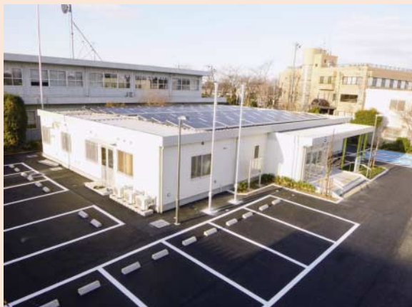
写真3-11-1 自動車税事務所太陽光発電設備
