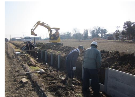
水路の整備 (施工中)
