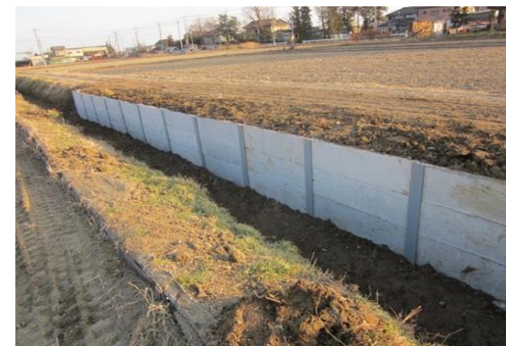
水路の整備 (完成)
