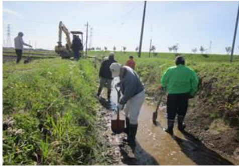
水路の泥上げ
