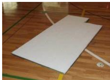
東日本大震災で落下した天井パネル
