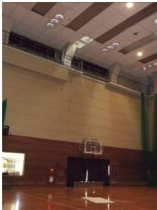
東日本大震災で落下した天井パネル
