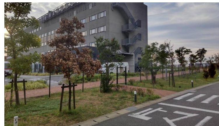
歩行者空間沿いの積極的な敷地内緑化
