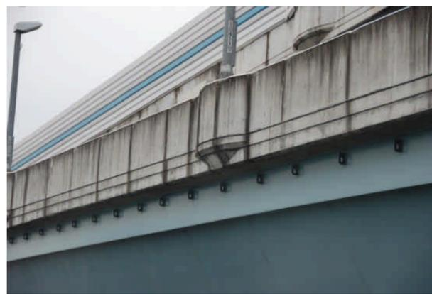
首都高速道路の壁高欄。照明等の設置箇所には曲面を使った張り出し部を設けた事例。これらのような壁面の造形には（型枠工などの）手間はかかるが、大きなコストアップにはつながらない。
