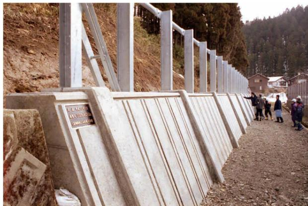
型枠面木により造形（スリット）を施したロックキーパー。支壁とスリットが擁壁全体のプロポーションを整えるとともに、スリットが表情を与え、深みのあるデザインとなっている。また、上部のスリットは、水切りの役目も果たしている。擁壁にも応用が可能なデザインである。
