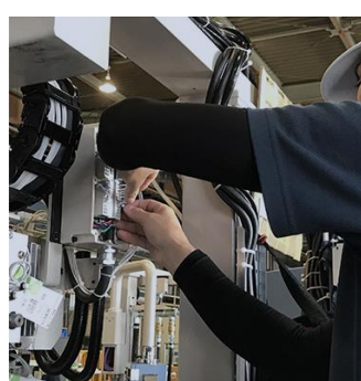
期待配線工事
