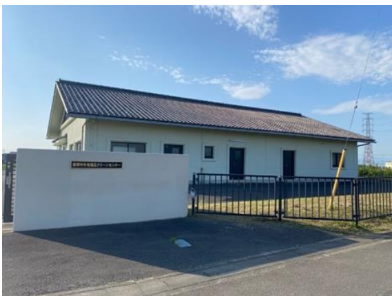
農業集落排水施設
