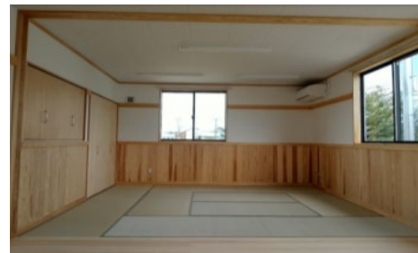
2階内部畳・腰壁・漆喰壁 (杉戸町)
