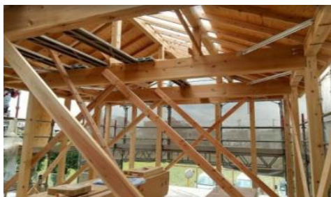
2階の構造体、火打ちは鋼製 (杉戸町)
