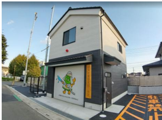
消防団分団小屋の外観 (杉戸町)
