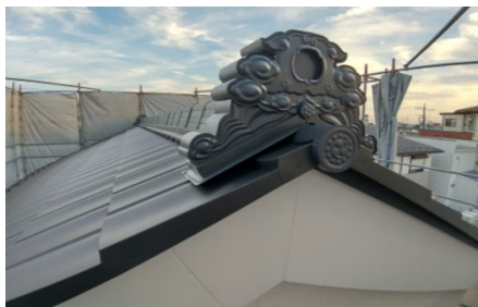
屋根の鬼飾り (屋根瓦共に鋼板製) 意匠性と耐震性を両立 (杉戸町)
