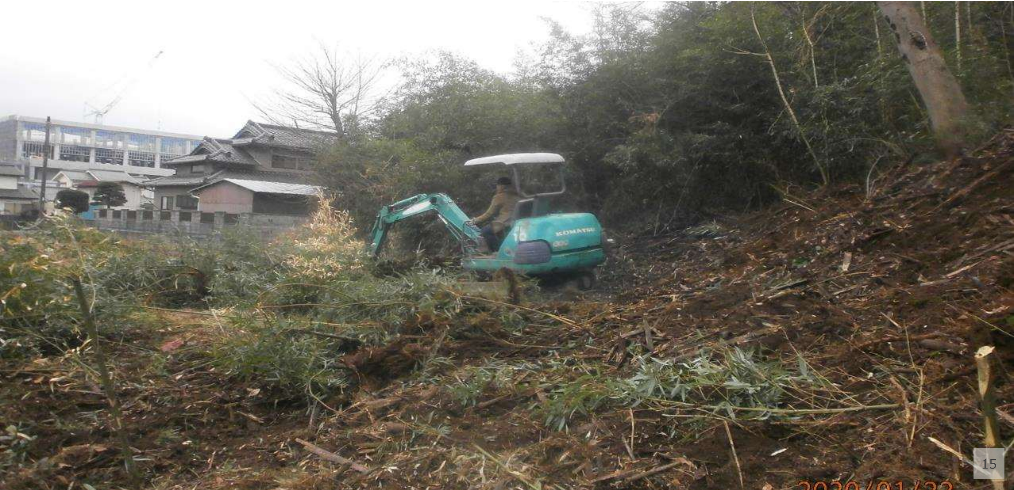
平成31年から活動開始 まずは開拓 重機を入れての伐根、整地
