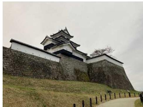
(小峰城：東日本大震災で石垣が崩れ修復を行った)
