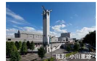
撮影:小川重雄 芸術劇場外観
