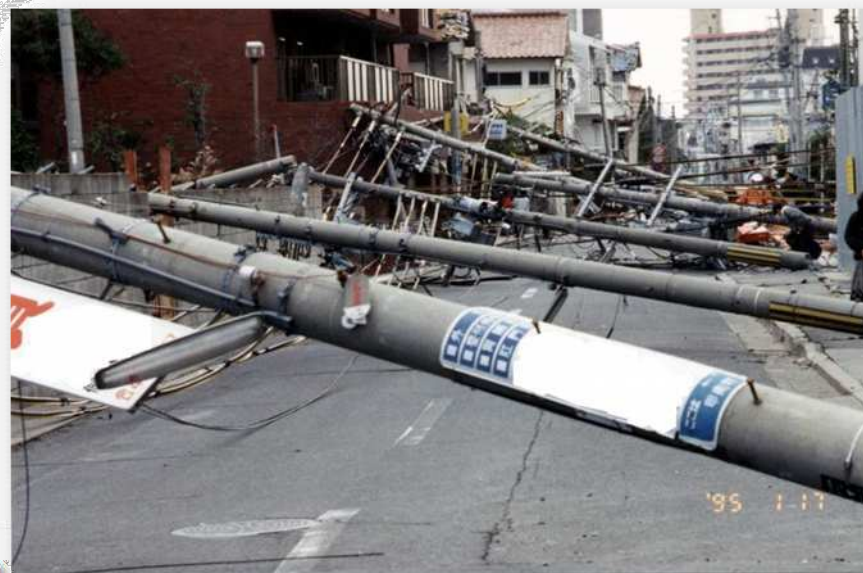
地震時の電柱倒壊（阪神淡路大震災）
