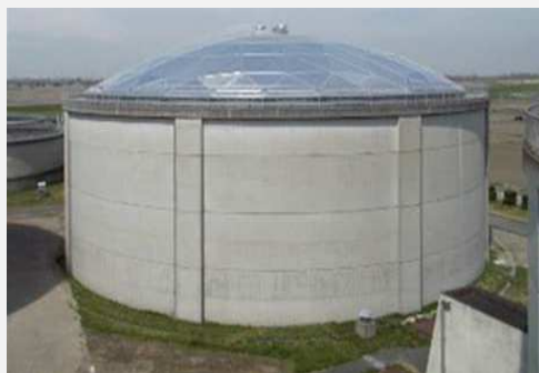
備蓄施設 (P C 浄水池)
