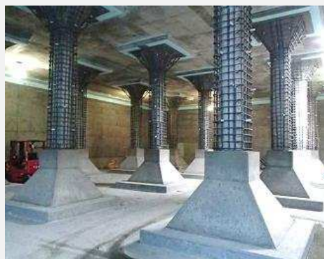
浄水池 柱補強状況
