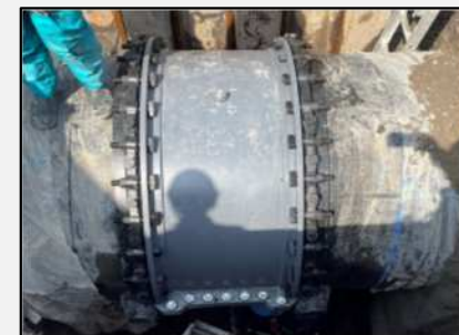
漏水復旧の状況
