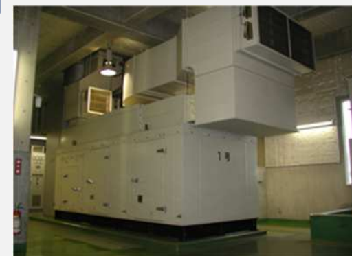
非常用発電設備
