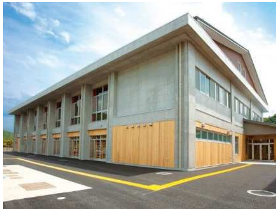
RC造・木造の複合による準耐火建築物（小鹿野小学校体育館／小鹿野町）
