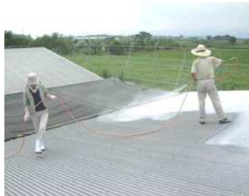
石灰の吹き付け（宮崎県）
