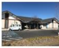
【太陽光発電設置施設】
