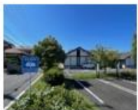
【公共施設のEV充電施設】
