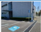
上里町役場EV充電スタンド
