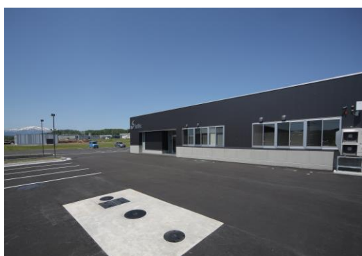
2020 年 5 月稼働の新工場(山形県)
