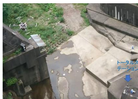
エンムスビ 7 号を使った宮城県 鳴子ダム自動点検撮影の様子
