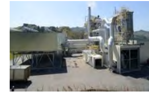
真庭バイオマス発電株式会社 〈地域関係団体が構成する新会社〉
