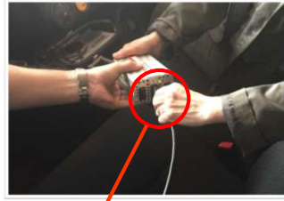
インバーターとコードリールを接続
