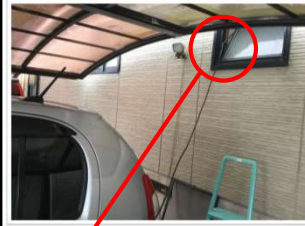
自宅前の駐車場から、トイレの窓を利用して室内へ。
