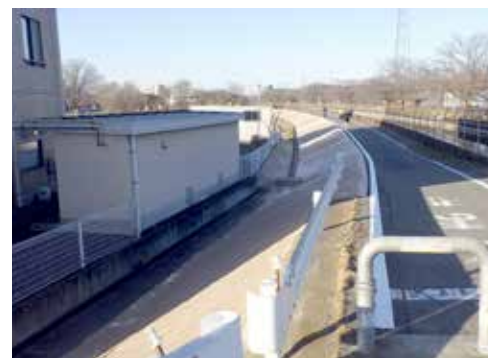
▲整備後(土系舗装を施工)
