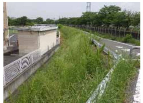
▲整備前の状況(蓮田市内)
