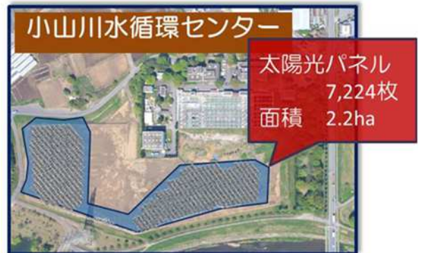
事例④：太陽光発電 (小山川)
