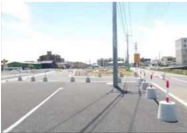
供用開始区間（北側から見た様子）
