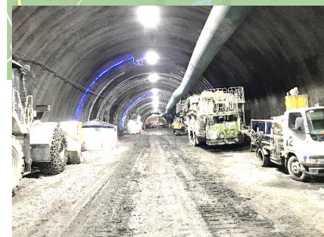
トンネル坑内全景 トンネルを掘るための機械を坑内へ置くことができました。
