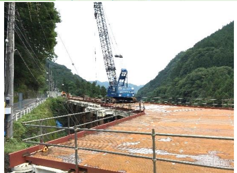
トンネルより秩父市内側で仮橋橋工事を進めています。
