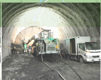
装薬状況 岩盤に穴をあけて、火薬を入れて発破の準備をしているところです。
