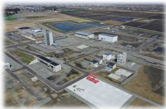
福島ロボットテストフィールド 全体風景
